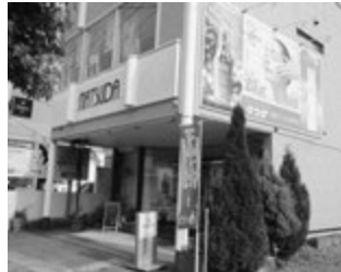
▲外壁の特大看板
